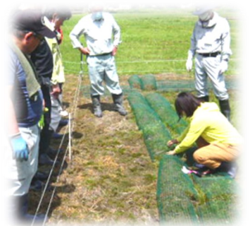
設置作業の様子
