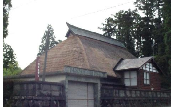
▲ 茅葺屋根改修後の鴨井家住宅主屋（板倉区）
