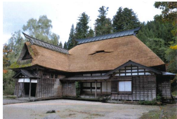
▲ 茅葺屋根改修後の旧飯田家住宅主屋（大島区）
