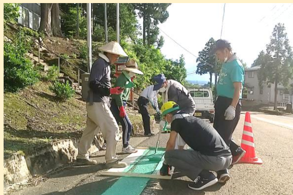
グリーンライン設置作業
