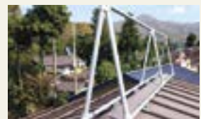
命綱固定アンカーの設置例
