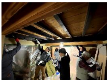
(空き町家のリノベーションの様子)
