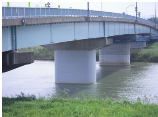
(2) 耐震化された春日山橋
