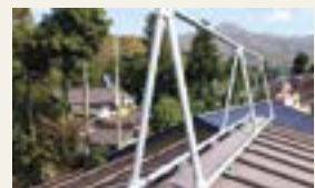
命綱固定アンカーの設置例
