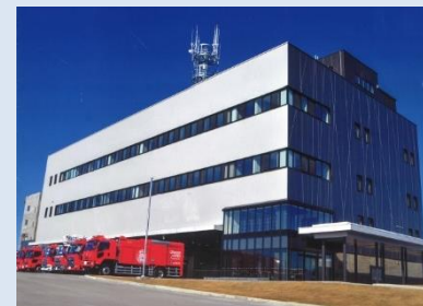
(整備された上越地域消防局・上越消防署)
