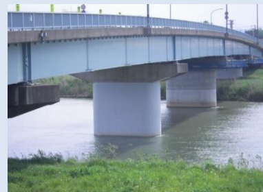
(耐震化された春日山橋)
