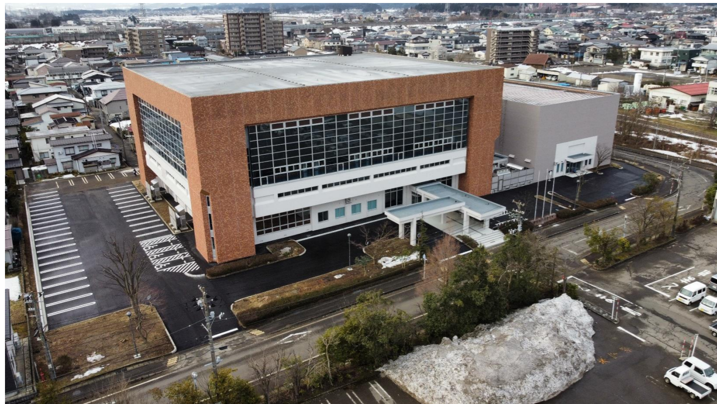
■ 令和3年度大規模改修を実施した上越市総合体育館、上越市勤労身体障害者体育館（外観）
