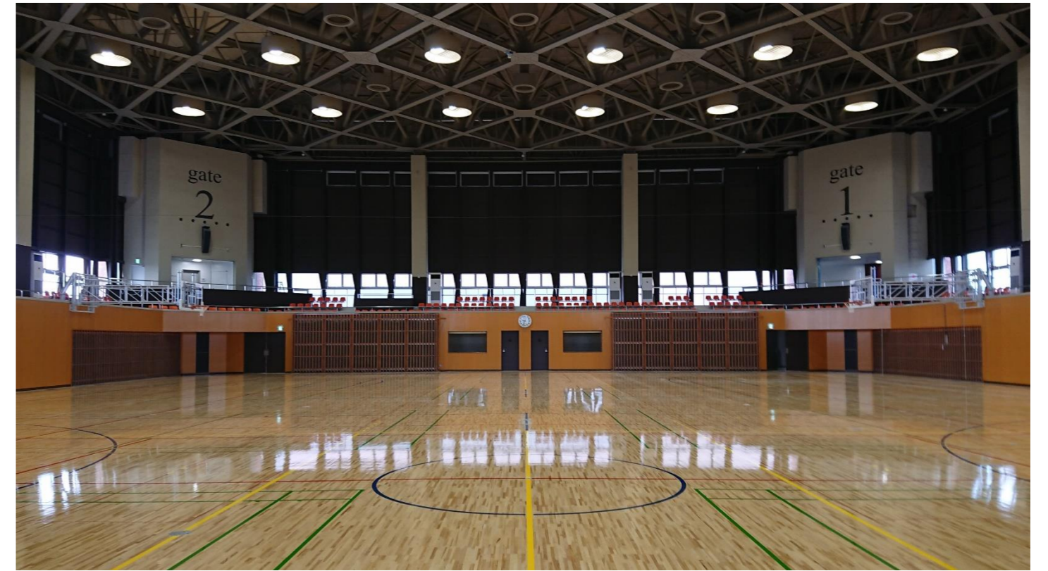
■ 令和3年度大規模改修を実施した上越市総合体育館、上越市勤労身体障害者体育館（アリーナの冷暖房）
