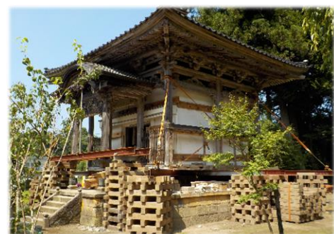
▲善徳寺経堂 修繕の様子
