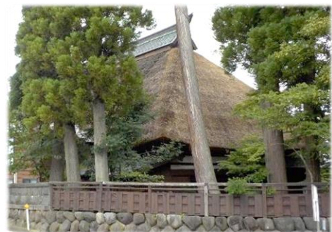
▲鴨井家住宅主屋茅葺屋根 葺き替え後
