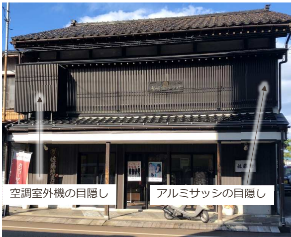
アルミサッシ、空調室外機が目隠し
