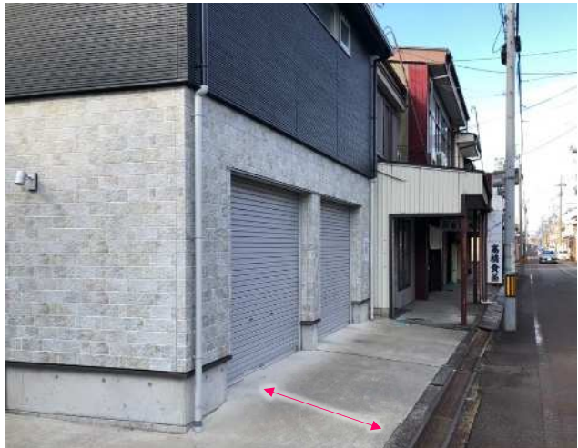
雁木通りとして通行できる空間を確保している例
