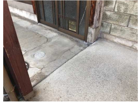
隣接する雁木、道路面との段差
