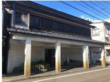
鉄筋コンクリート造
