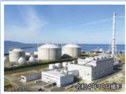
東北電力(株)上越火力発電所
