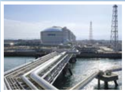
インベックス 株INPEX直江津LNG基地
