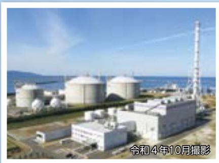
東北電力(株)上越火力発電所
