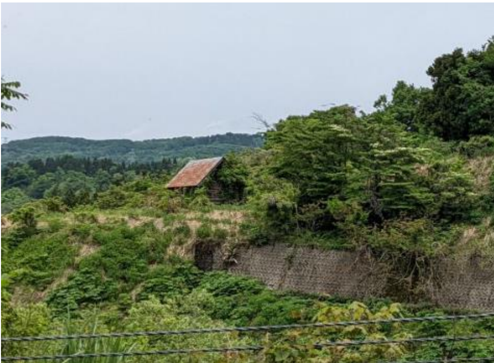
大島大山広場 休憩舎
