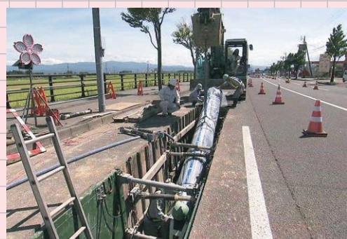
▲水道管の更新工事
