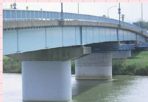
▲耐震化された橋梁（春日山橋）
