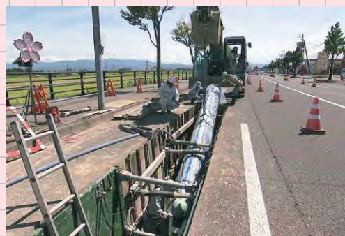
▲水道管の更新工事
