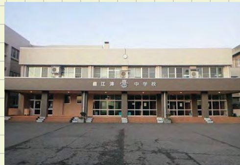
▲学校施設の外壁等大規模改修工事(直江津中学校)
