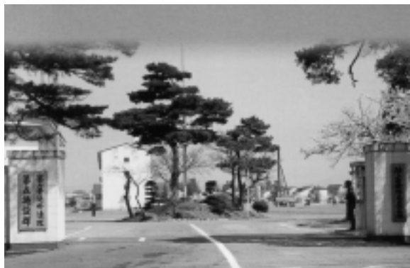
【図1-3-55 駐屯地正門】
