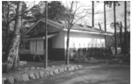
【図 1-3-10 公園内の公衆便所】
