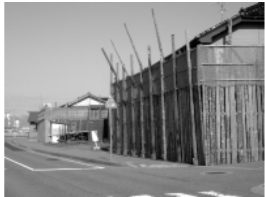
【図1-2-2 直江津の町並み(防風防砂壁)】
