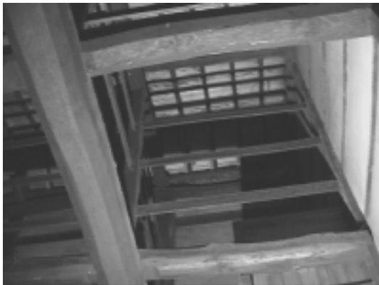
【図 1-3-41 町家の内部（吹き抜け）】
