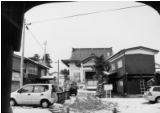
【図 1-3-53 境内地内の住宅】
