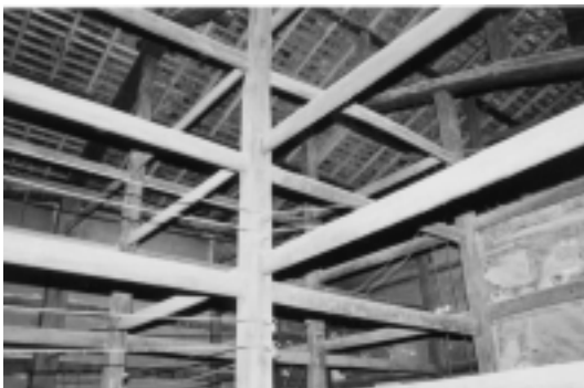
【図1-5-2 大島電機内部(吹き抜け)】
