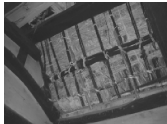
【図 1-4-10 建物内部からみた茅葺屋根】
