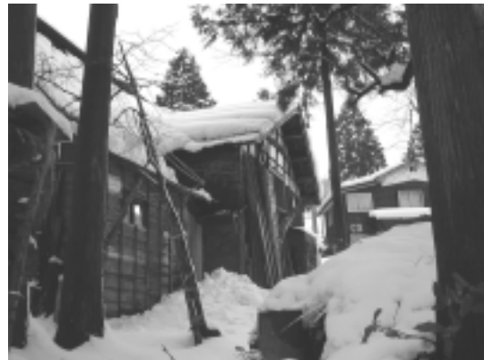
【図 1-4-8 建物の後へ突き出た中門】
