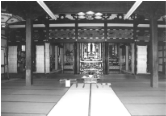
図 2-8 内部（外陣より内陣を見込む）
