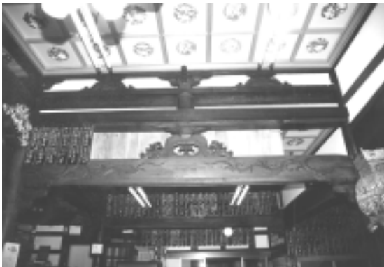
図 2-21 外陣（参詣の間）の架構
