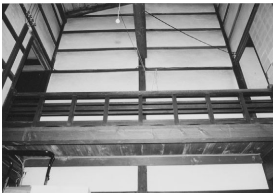
図1-38 旧呉服屋（本町6）の渡り廊下
