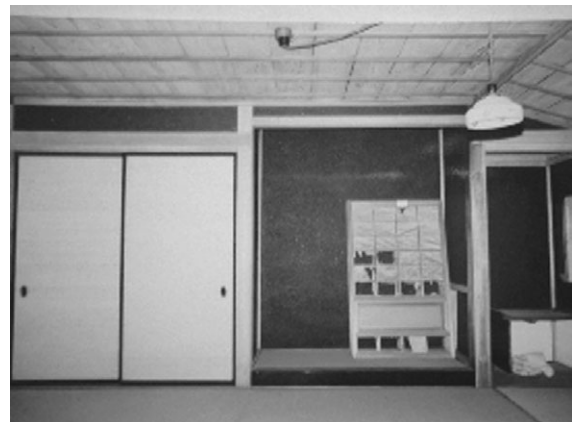
図3-2 旧広瀬家2階の床の間
