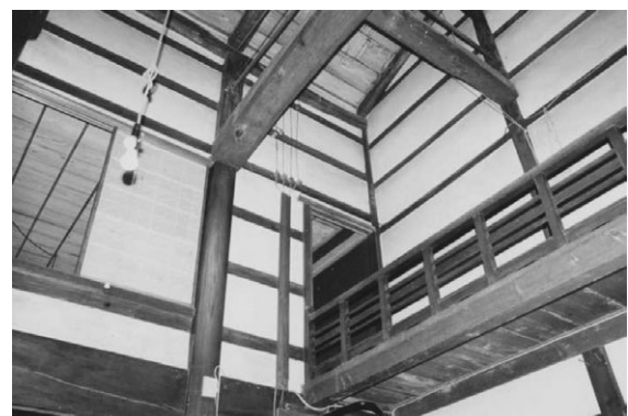
図3-3 旧広瀬家の吹き抜け
