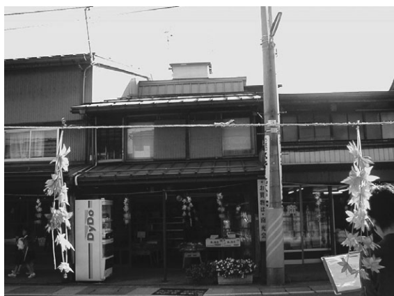
図3-7 No.17店舗兼住宅
