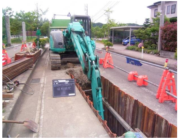
整備が進むインフラ(公共下水道工事の様子)
