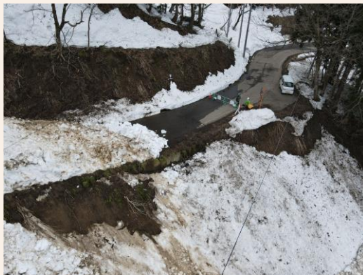
ドローンでの地すべり現場の空撮
