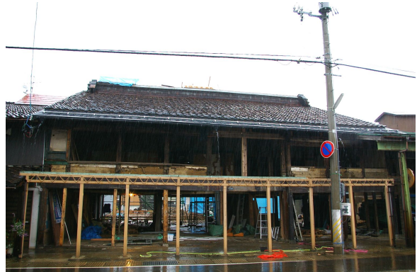
【写真7 町家の再生工事の途中経過】
