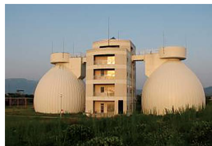
下水道センターの処理施設
