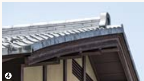
①小林古径邸(右)と画室(左) ②③柱と鴨居との接合部。「面中(めんなか)仕事」と呼ばれる施工方法で、鴨居は、面取りされた柱の角度がついた部分にぴったりと合うように加工され、接合されている ④緩やかにアーチを描く「むくり屋根」は、謙虚さや奥ゆかしさを表現している ⑤障子の組子も一本一本が全て面取りされている。近くで見ると、交差する部分は場所によって縦横の接合方法が異なっていることが分かる
