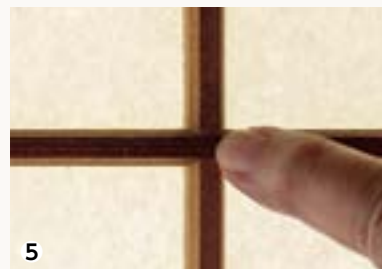
①小林古径邸(右)と画室(左) ②③柱と鴨居との接合部。「面中(めんなか)仕事」と呼ばれる施工方法で、鴨居は、面取りされた柱の角度がついた部分にぴったりと合うように加工され、接合されている ④緩やかにアーチを描く「むくり屋根」は、謙虚さや奥ゆかしさを表現している ⑤障子の組子も一本一本が全て面取りされている。近くで見ると、交差する部分は場所によって縦横の接合方法が異なっていることが分かる
