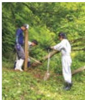
山道への案内標識の設置作業
