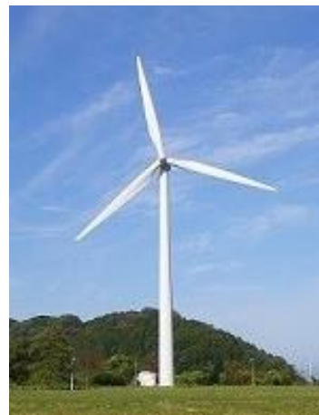
風力発電施設3号機
