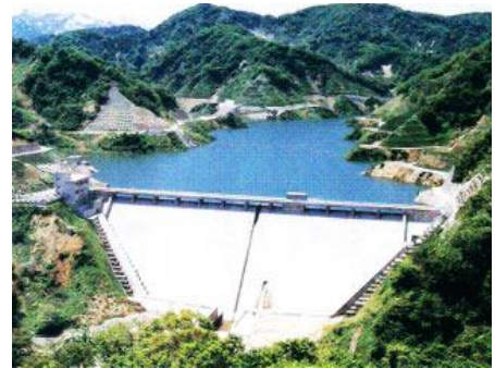
正善寺ダム（上正善寺地内）
