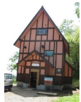
古民家再生住宅
