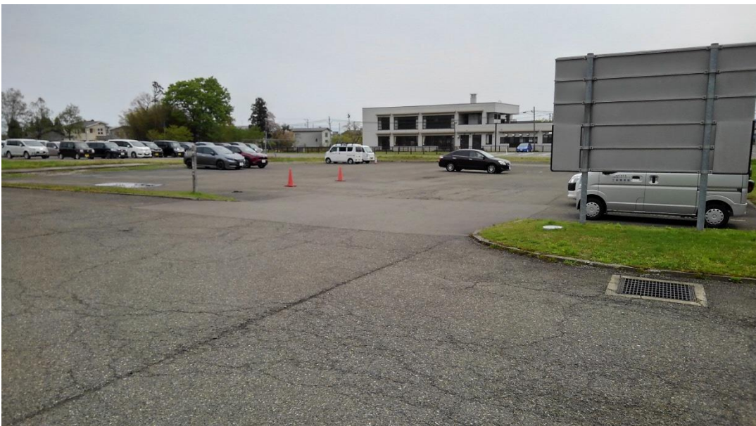
埋蔵文化財センター駐車場：左側（北側）が未舗装
