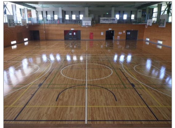
【体育館床面改修】
