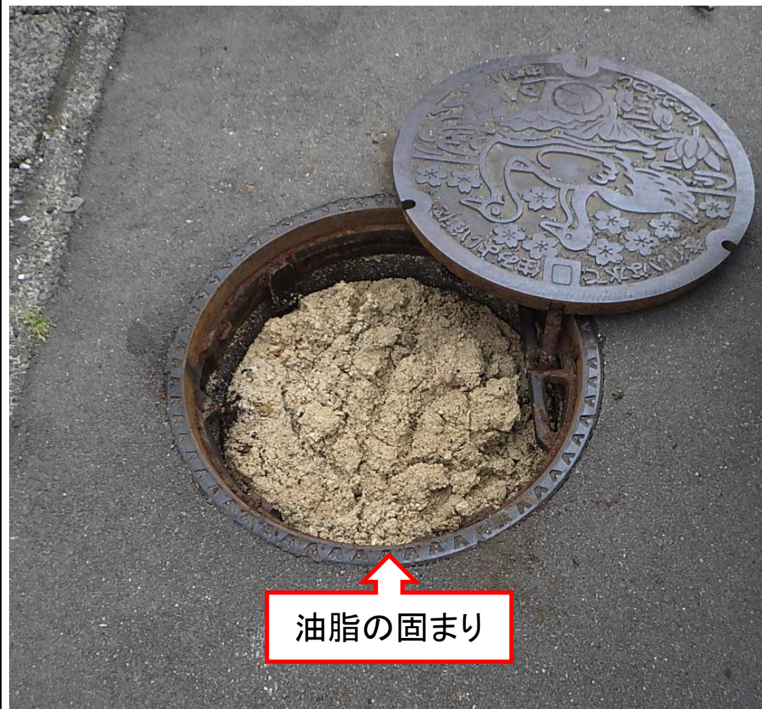
③ マンホールの状況
