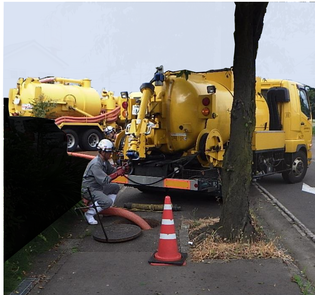
④ 復旧作業の様子
