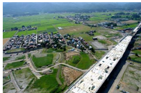
整備が進む上越(仮称)駅
