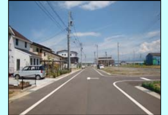
区画道路(区画整理地内)
