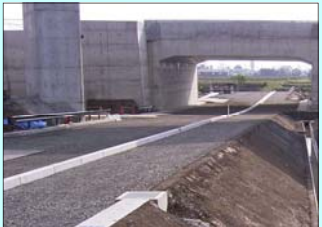
市道大和上中田線(工事中)
