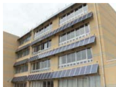
図 10-7 大町小学校の垂直設置事例
