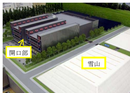
図 雪氷冷房を活用したデータセンターの模型 (出典：北海道グリーンエネルギーデータセンター研究会 HP)
